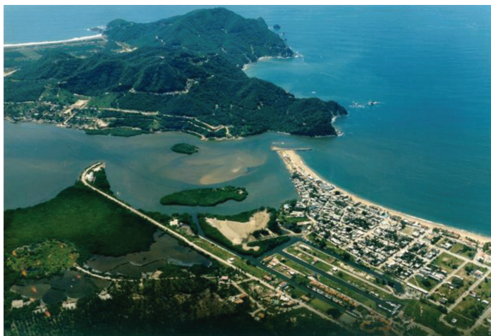
Figura 18. Construcción del área de varaderos y atracaderos en la boca de la laguna Barra de Navidad-Bahía Navidad (inicio de la modificación del área finales de los setenta). Fuente: Ramiro Flores Vargas.
