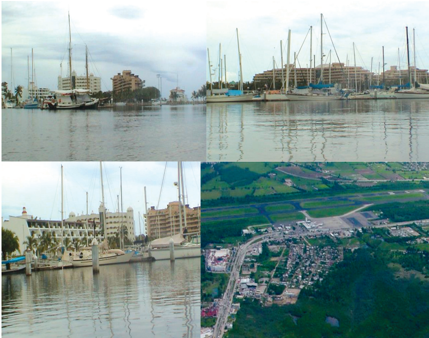
Figura 2. Fragmentación del sistema estuarino El Salado por la construcción de la marina Vallarta y el aeropuerto internacional Adolfo López Mateos , Puerto Vallarta, Jalisco. Fuente: Luis F. González Guevara.
